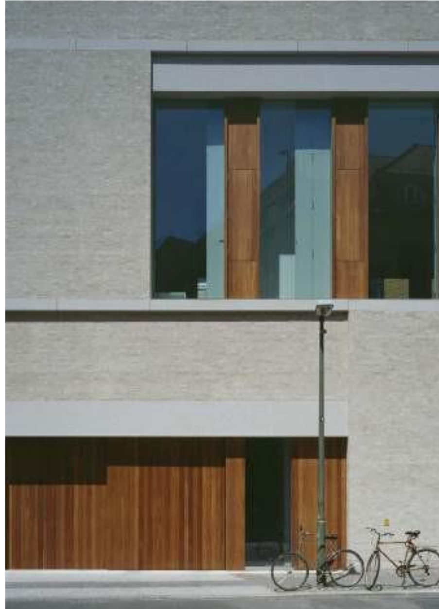
2.2 Brique chaulée, béton blanc et menuiseries bois Galerie à Berlin, David Chipperfield
