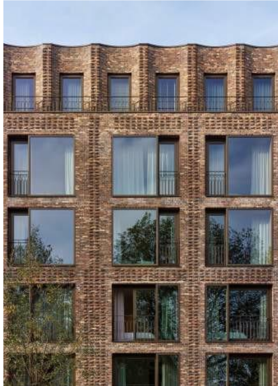
2.17 Façade à reliefs, Mise en oeuvre courbe, briques en débord Hôtel à Amsterdam, Office-Winhov
