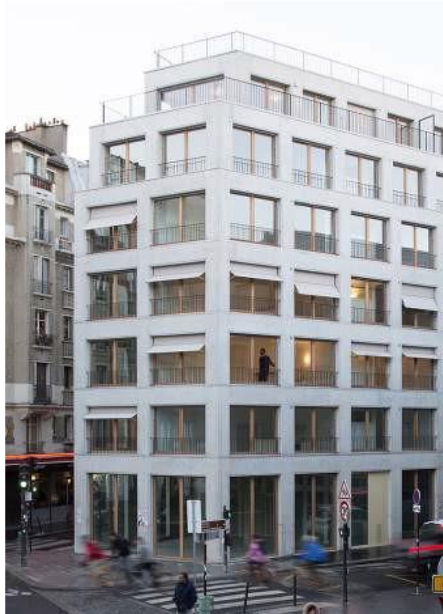
2.11 Béton clair effet pierre Logements à Paris, Armand Nouvet
