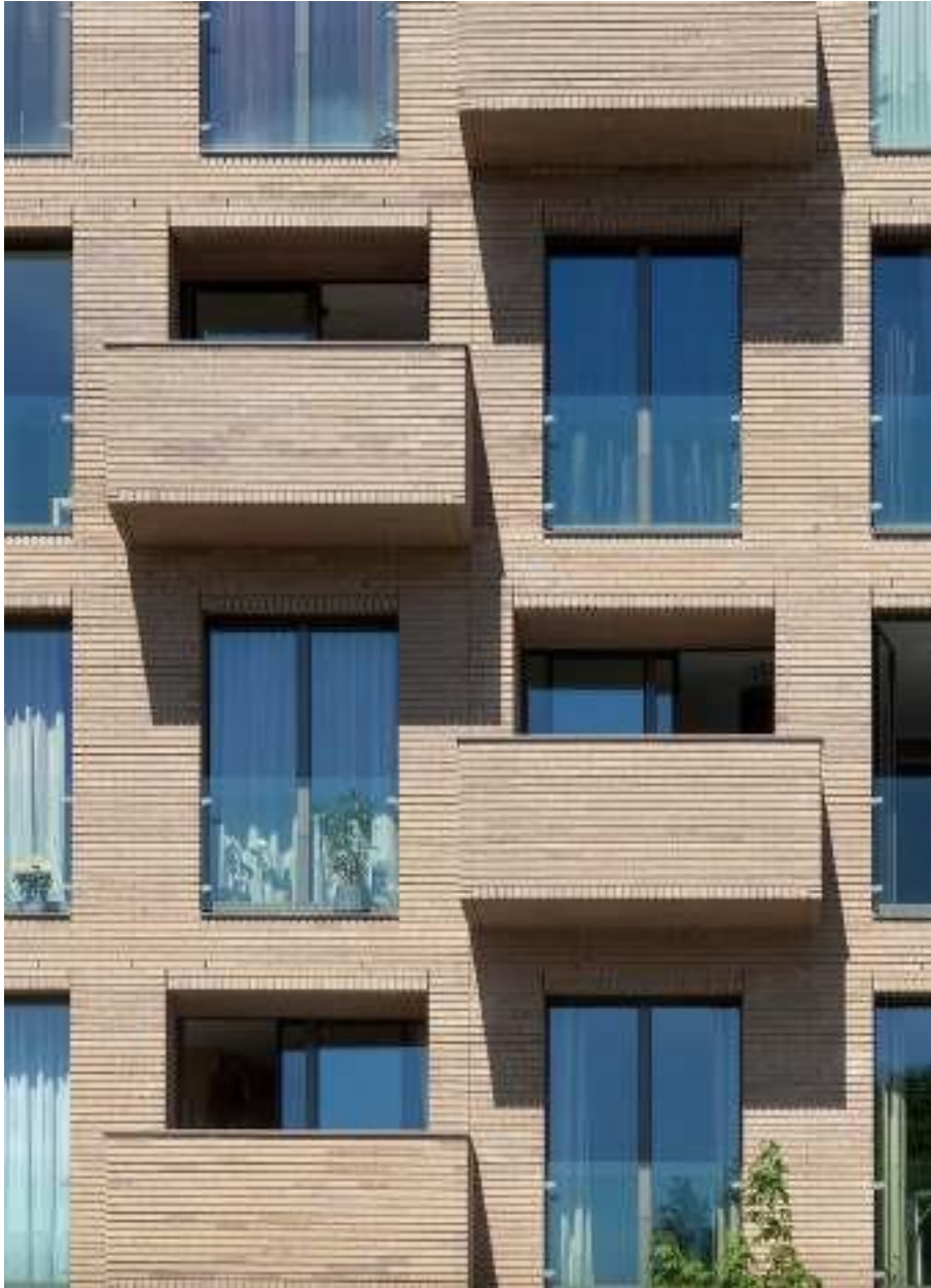
3.7 Loggia en débord avec allège pleine Logements à Utrecht, Bedaux de Brouwer architecten
