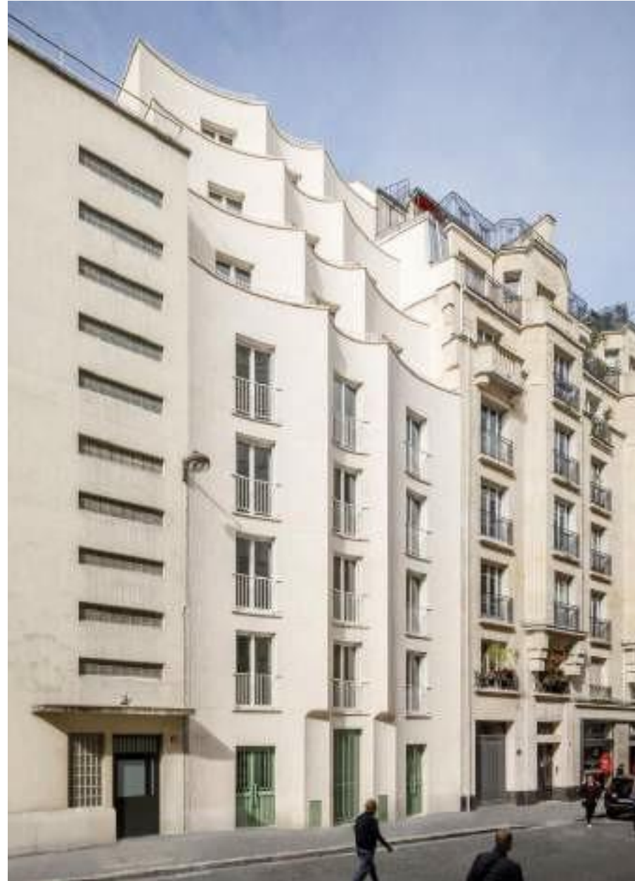
2.8 Pierres autoportantes en façades, travaillées en reliefs
