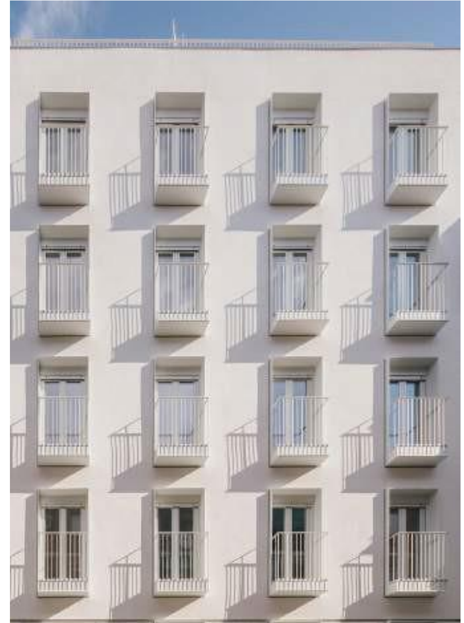
3.9 Loggia plongeoir systématique Logements à Madrid FRPO Rodriguez & Oriol
