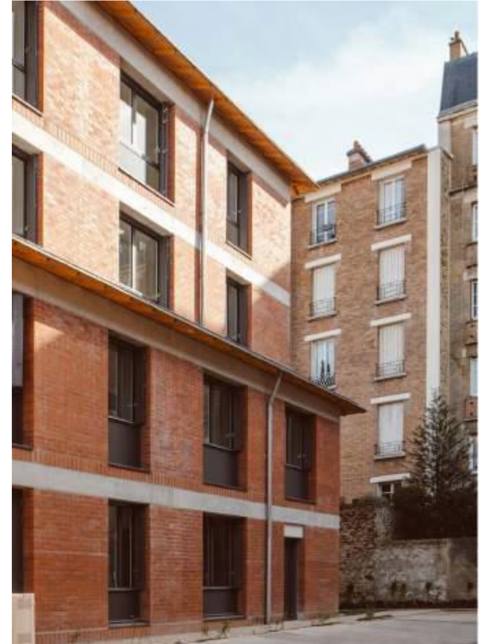
2.3 Brique de terre cuite et béton Logements sociaux à Paris, Barrault Pressacco
