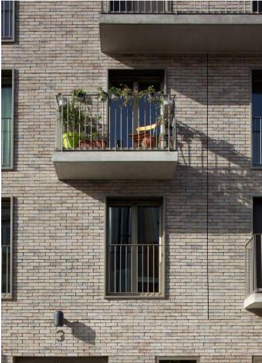
2.13 Brique de terre cuite teinte foncée Logements à Paris Hardel Le Bihan architectes
