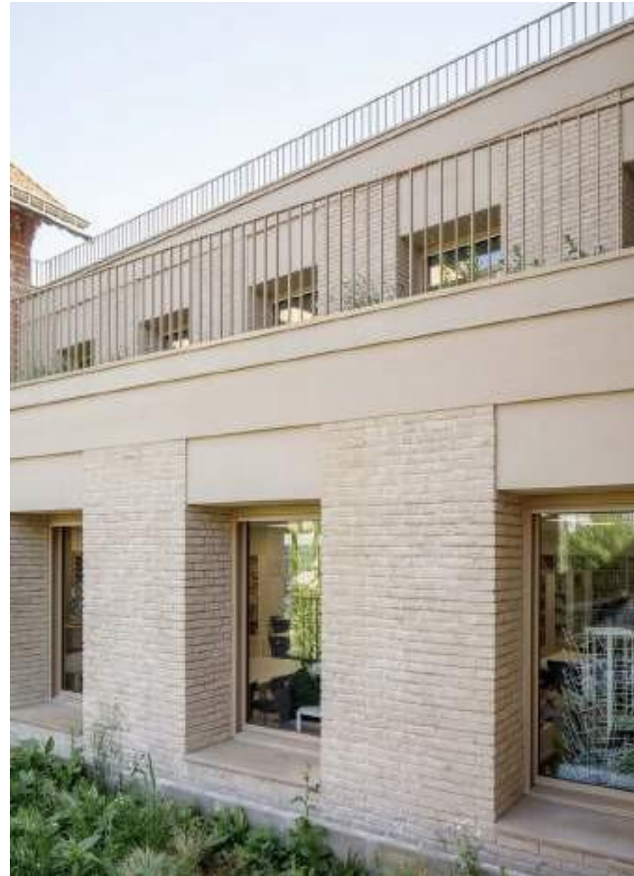
2.5 Façade mixte briques - béton Lycée Notre-Dame des Oiseaux, Paris 16 Bien Urbain, Atelier d'Architecture
