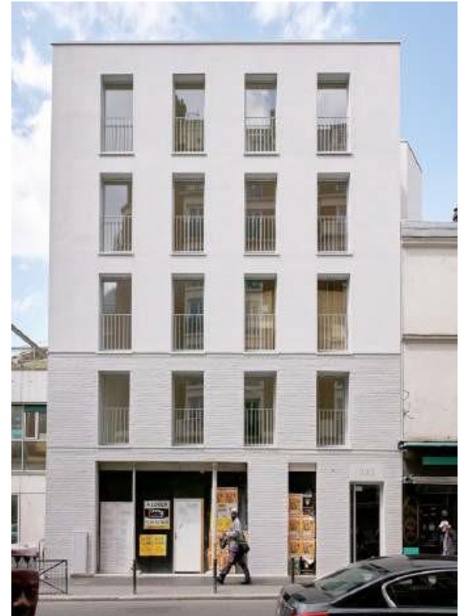
2.6 Socle en briques et corps en béton peints Logements à Paris, Septembre architecture
