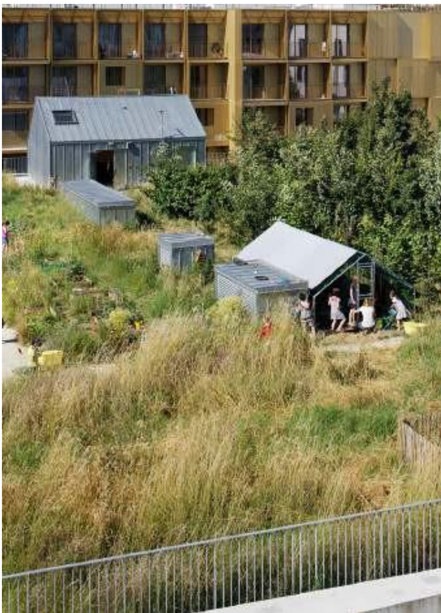
4.1 Toiture Intensive Ecole de Boulogne, ChartierDalix
