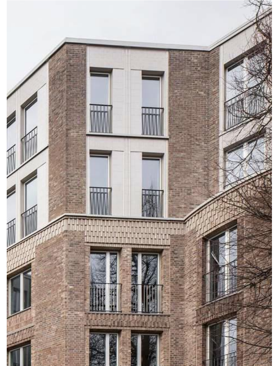
2.18 Modénatures variées sur l'ensemble de la façade et attique marqué Logements à Londres, Sergison Bates Architectes
