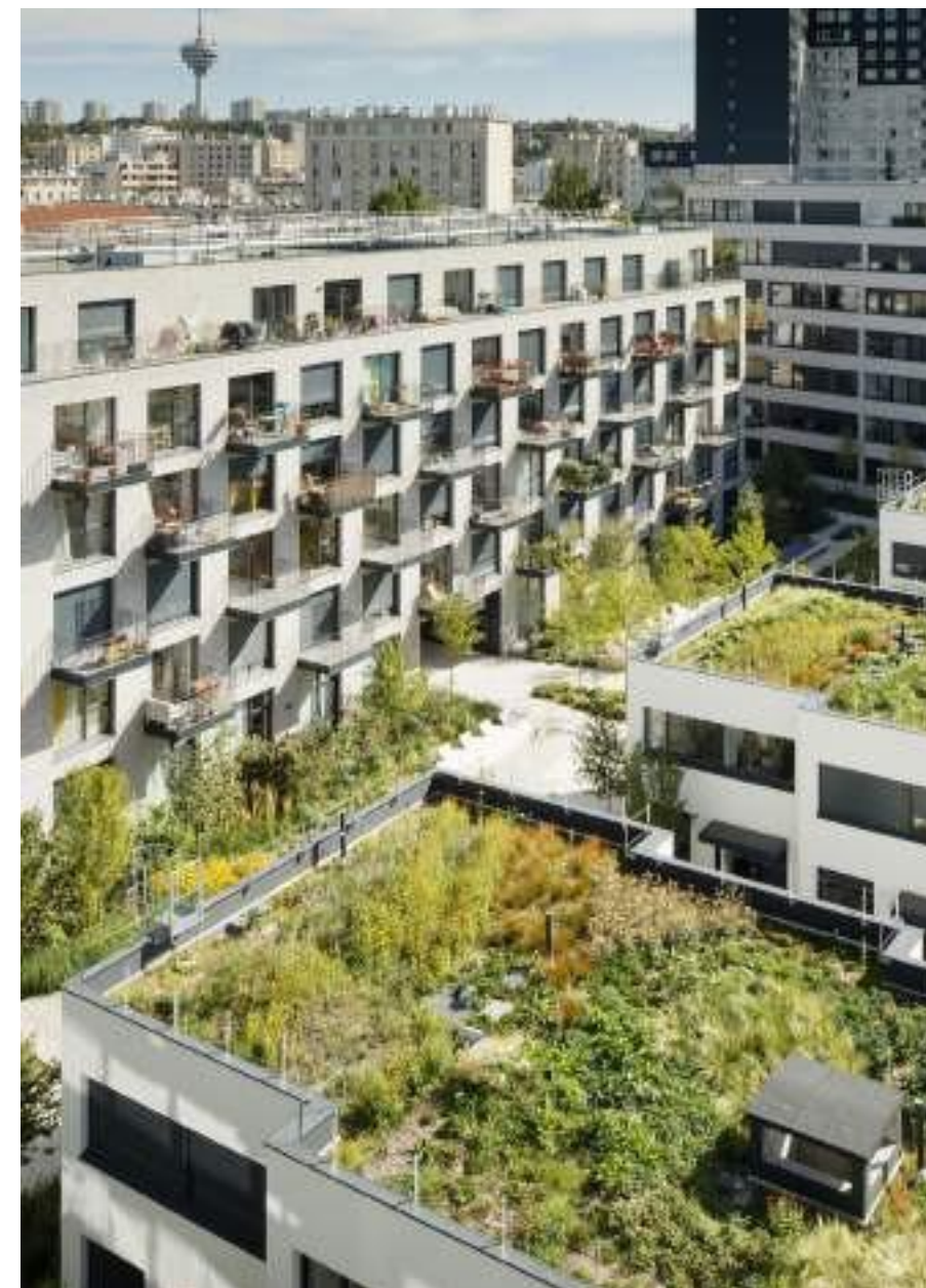
4.3 Toiture Semi-intensive Maisons de Pantin, ChartierDalix
