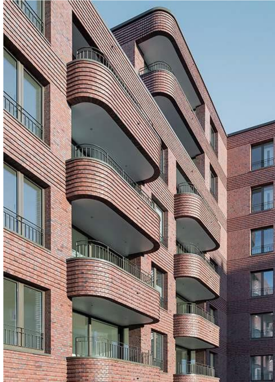
3.8 Loggia en débord avec allège pleine arrondie Logements Herne Kleihues + Kleihues
