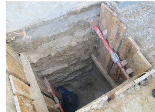
Exemple de reconnaissance de fondation
