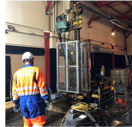
Exemple de forage géotechnique
